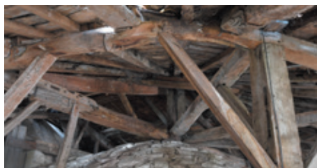
> Les travaux concernent le chœur, le transept et les absidioles de l'édifice (ci-dessus) avec l'obligation de reconstruire la charpente qui menace l'effondrement (ci-dessous).
